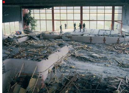
1985 versagte die abgehängte Betondecke eines Hallenbades im schweizerischen Uster. Die Aufhängungen der Decke aus nicht rostendem Stahl zeigten rein äußerlich keinerlei Mängel, waren jedoch innerlich teilweise vollkommen durch Spannungsrisskorrosion zerstört.
