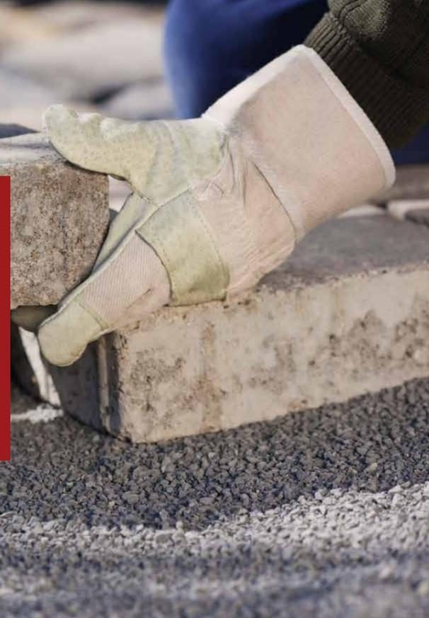
Unsere Streu- und Pflastersplitt eignen sich zum Beispiel für den Unterbau von Terrassenplatten und Pflastersteinen. Nach dem Rütteln bildet das Splittbett ein stabiles Fundament, dadurch können die Pflastersteine nicht wackeln oder verrutschen.
