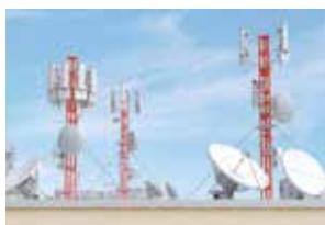
Antennen und Masten
