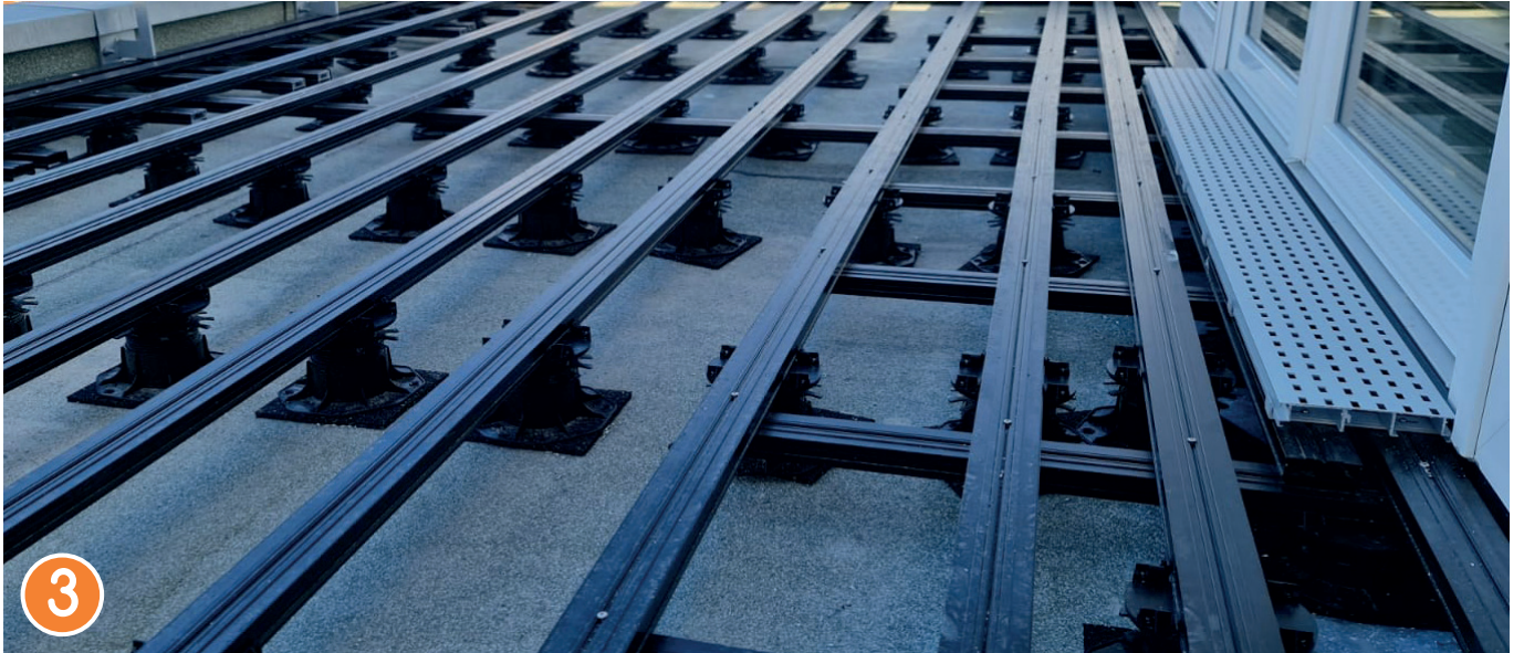
Dachterrasse/Laubengang auf Gefälledämmung mit Abdichtung
